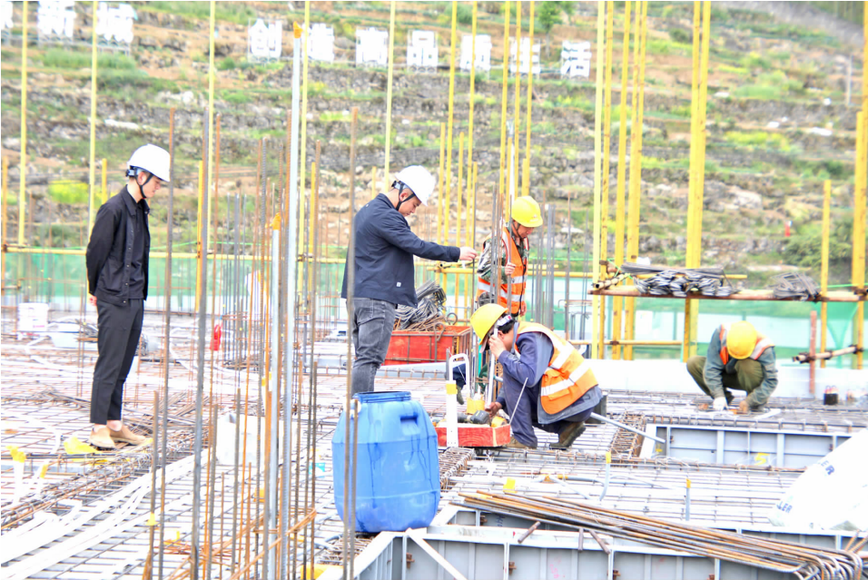
新城项目施工现场。 资料图片
