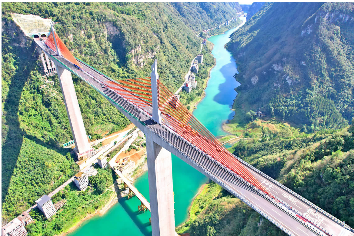
磨寨乌江特大桥。
