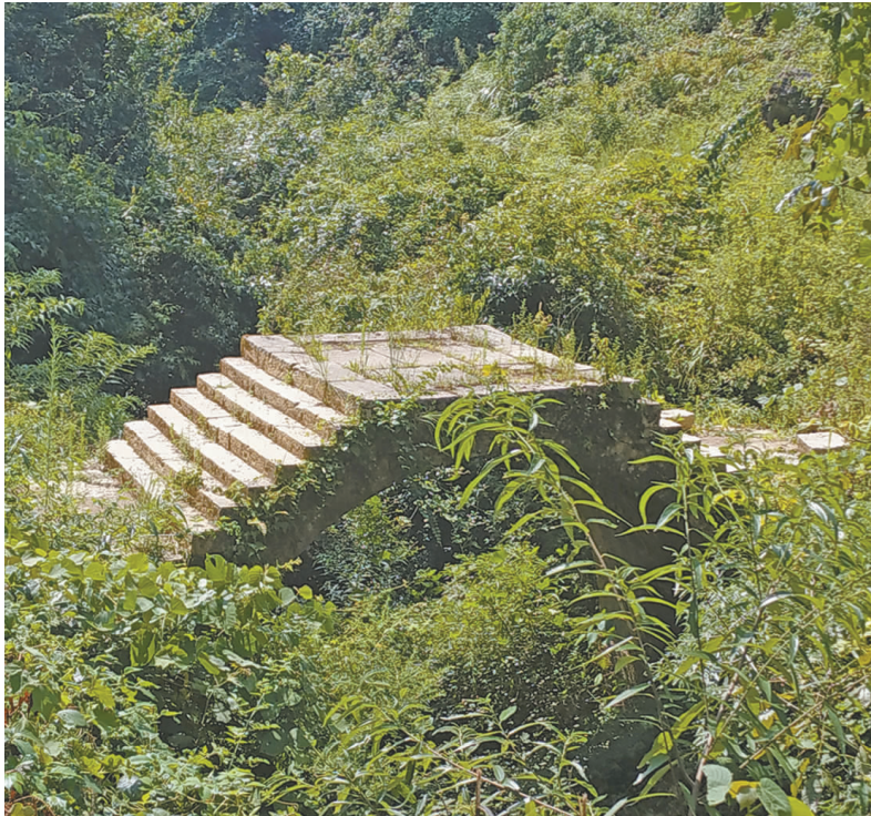
川盐古道上的石拱桥。
