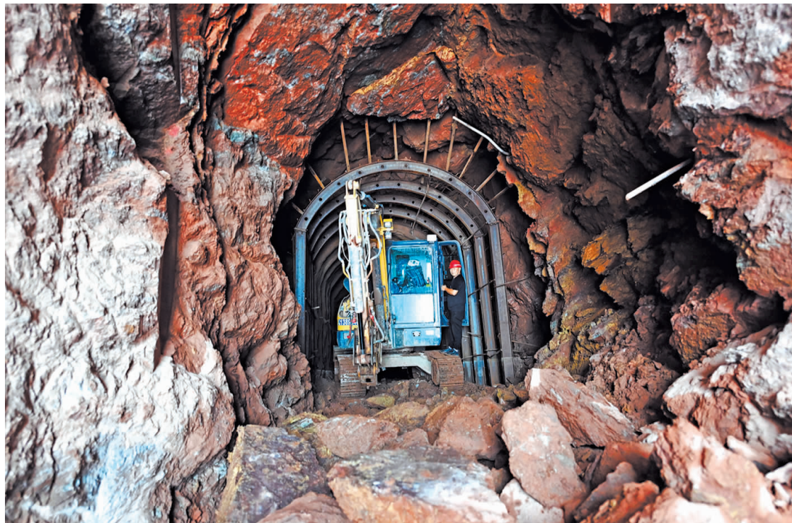
挖掘机从贯通的隧道口驶过。
