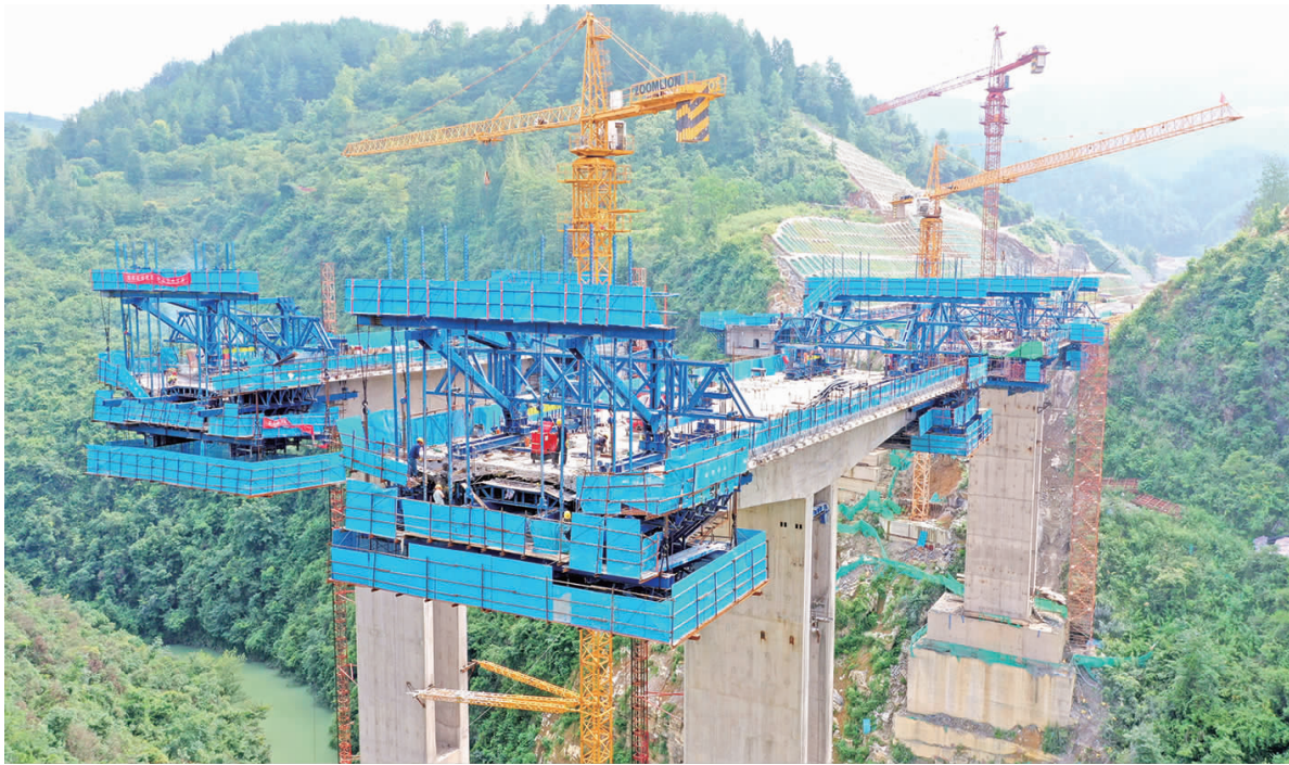
建设中的董河大桥。
