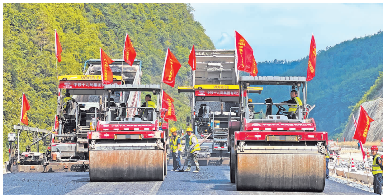
施工人员在试验段铺设沥青。
