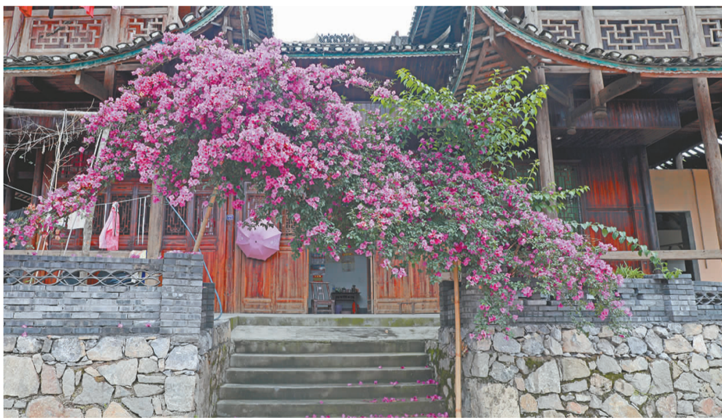
工人对景区内房屋进行风貌改造。
