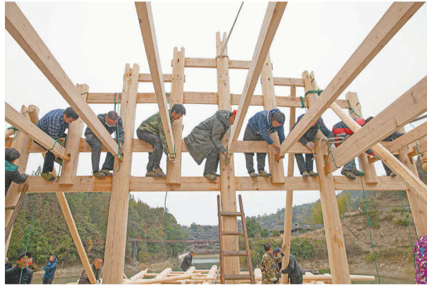
架楼梁,立新房。
