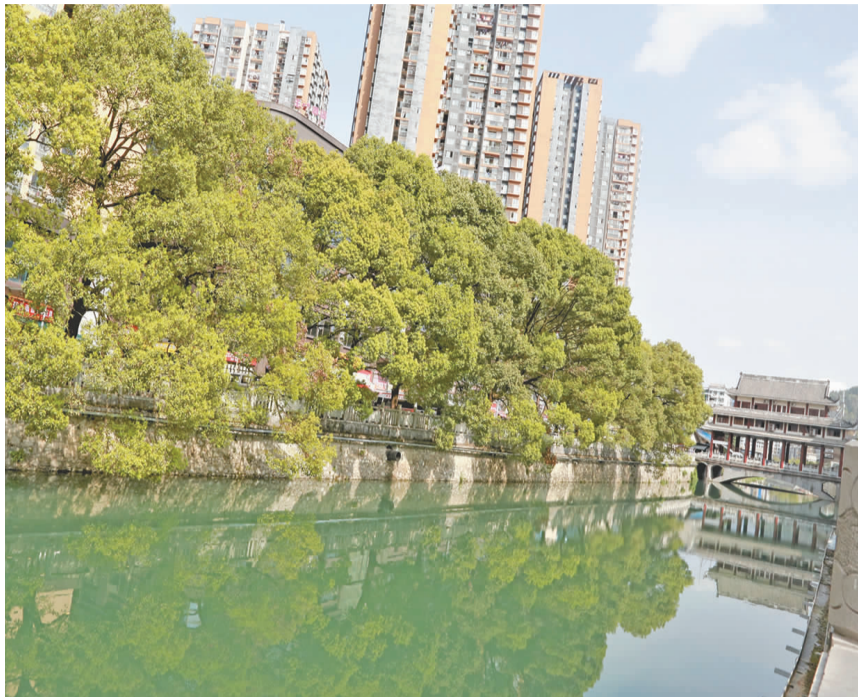
蓄水后的酉阳河一角。
