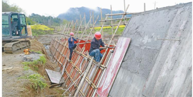
本报讯(融媒体中心记者白凤英/图)近日,在五福镇五福村集镇大桥下两河交汇处的河岸一侧,几名工人正在紧张有序地浇筑混凝土,一面河堤护坡墙已初见雏形(如图)。
