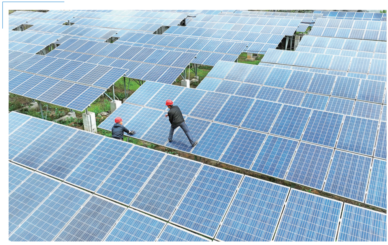
3月26日,小河镇小岗村,工人们正在检修光伏发电板。
