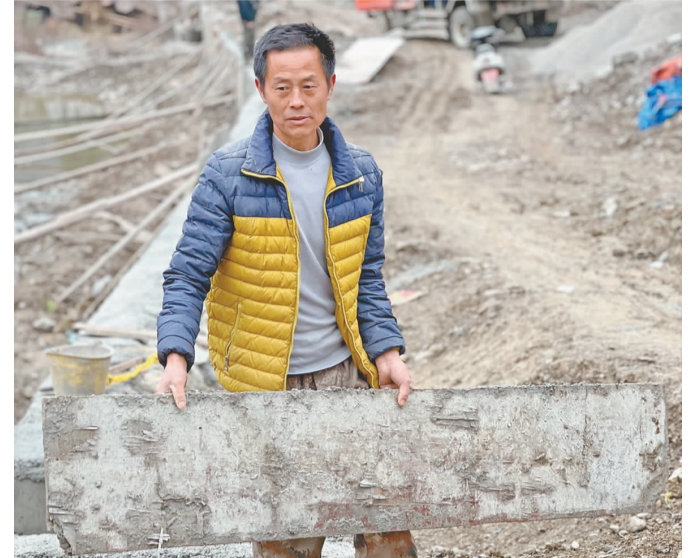
田茂友正在修路。
