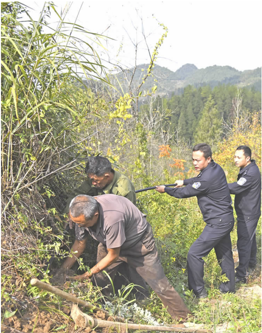
▲警民一起铺设管道。
