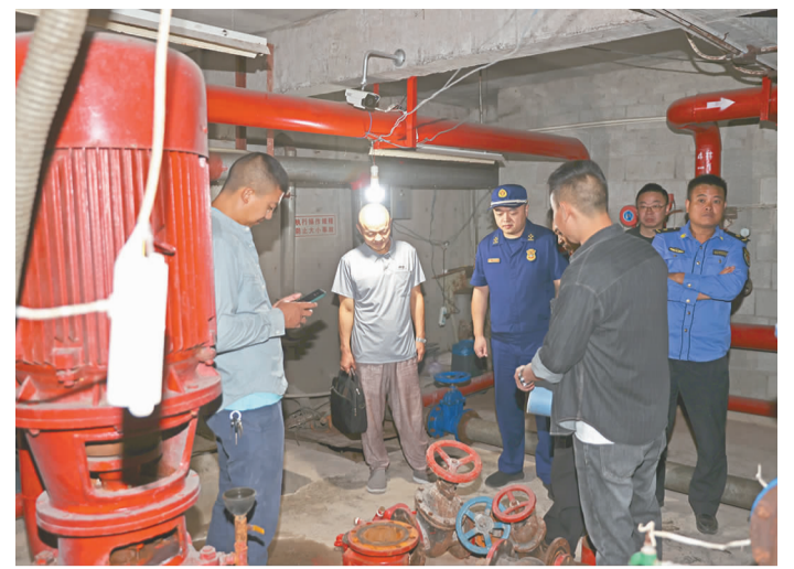
工作人员正在开展消防安全检查。
