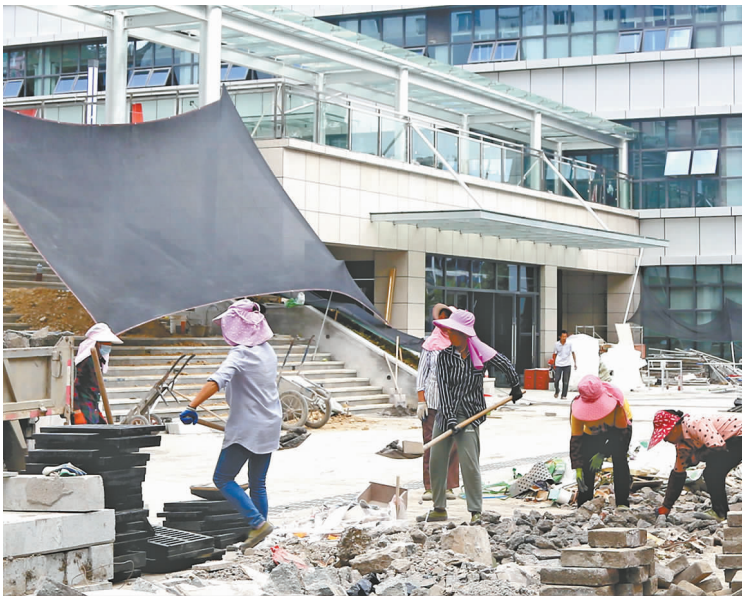
工人正在对路面进行铺装。
