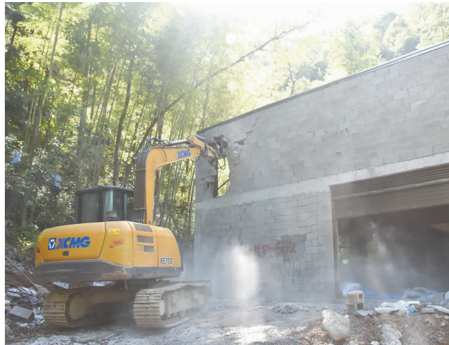
违章建筑拆除现场。
