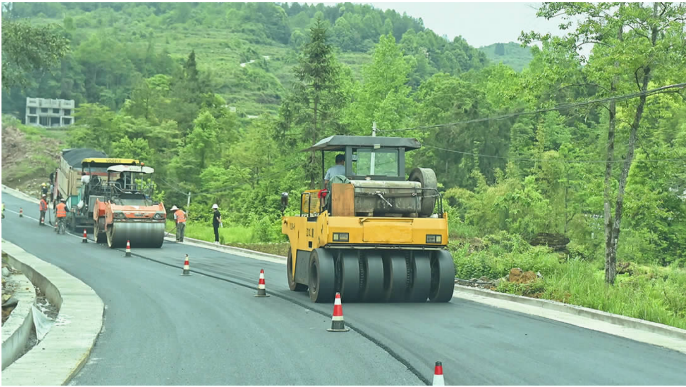
施工人员正在铺设沥青。
