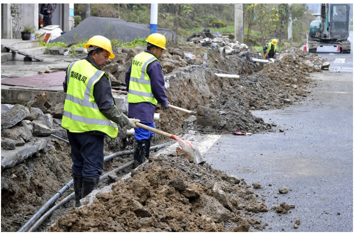
工人在开挖水沟。
